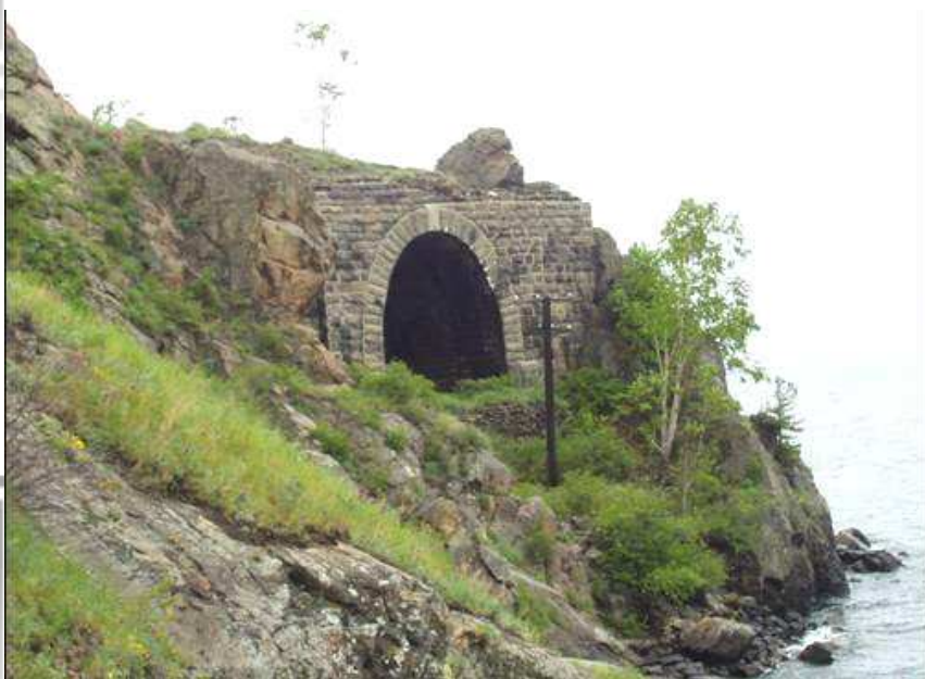
Кругобайкальская железная дорога (Слюдянский район, Иркутская область)
